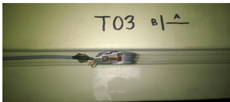
Obr. 6. Umístění těčka a směry tenzometrů T03a a T03b na podélném těsnicím a nosném koutovém svaru 16 mm v roce 2020.
