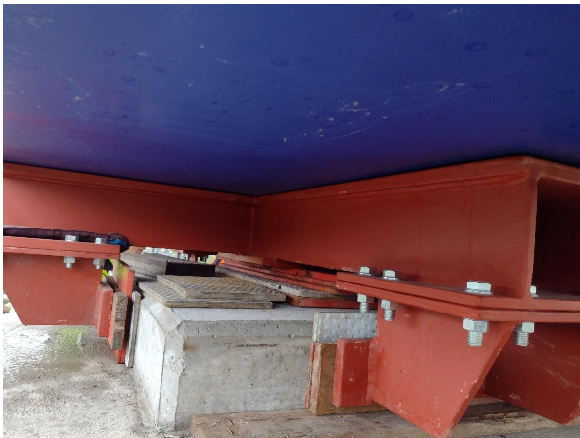
Obr. 8 – Montážní zajištění pevného bodu
