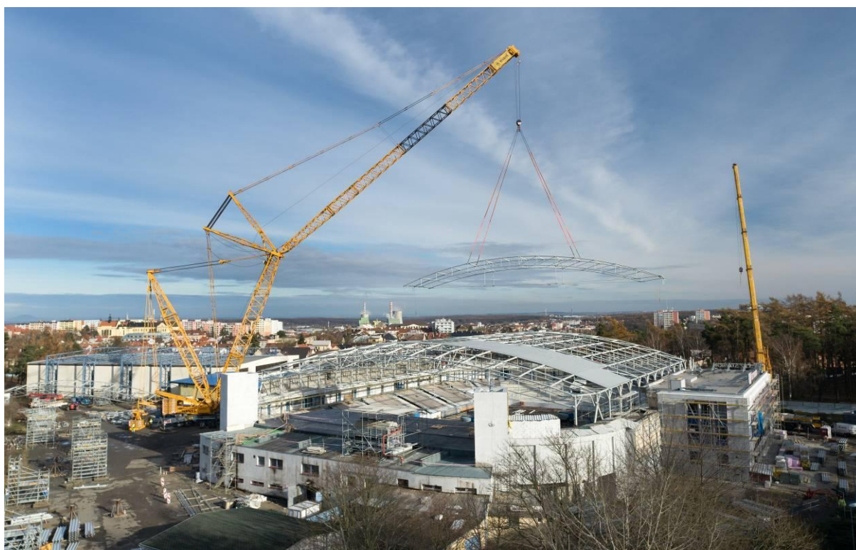
Obr.6 – Montáž ocelové konstrukce střechy a opláštění
