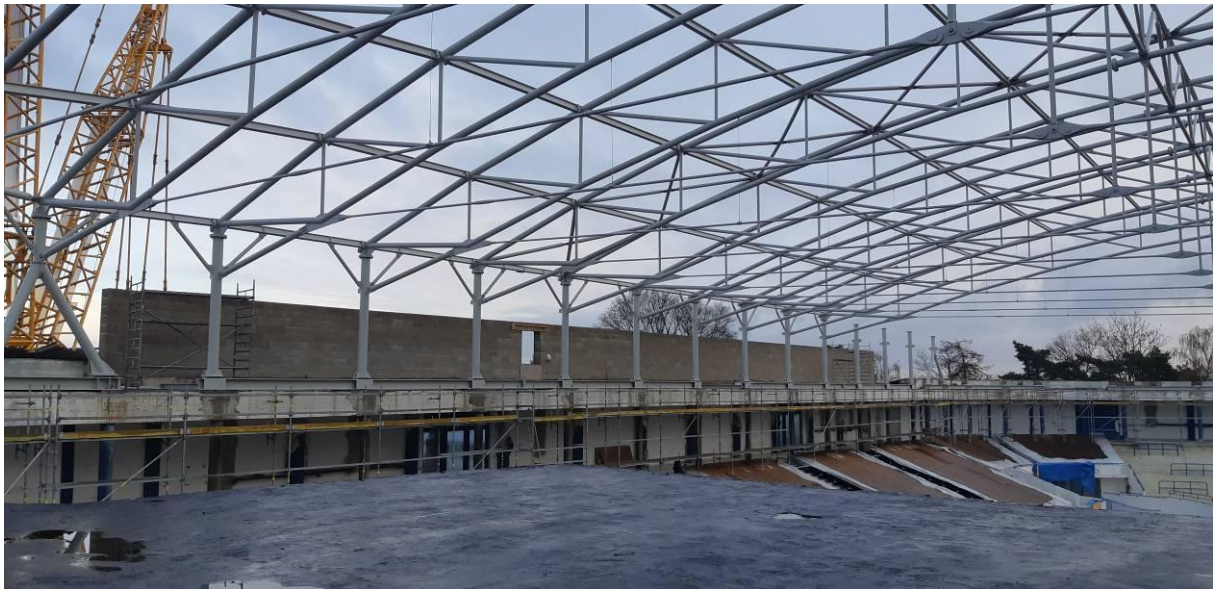
Obr.7 – Uložení vazníků na sloupy a zesilující průvlak
