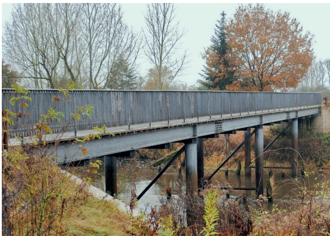
Obr. 3 – Takzvaný „ropný most“ (zdroj Institut Feuerverzinken)
