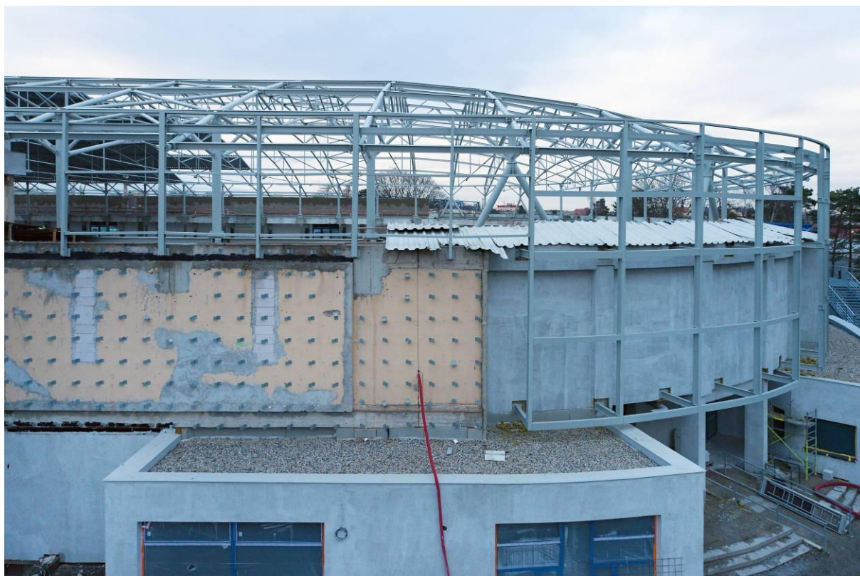
Obr.8 – Nosné konstrukce rohů haly
