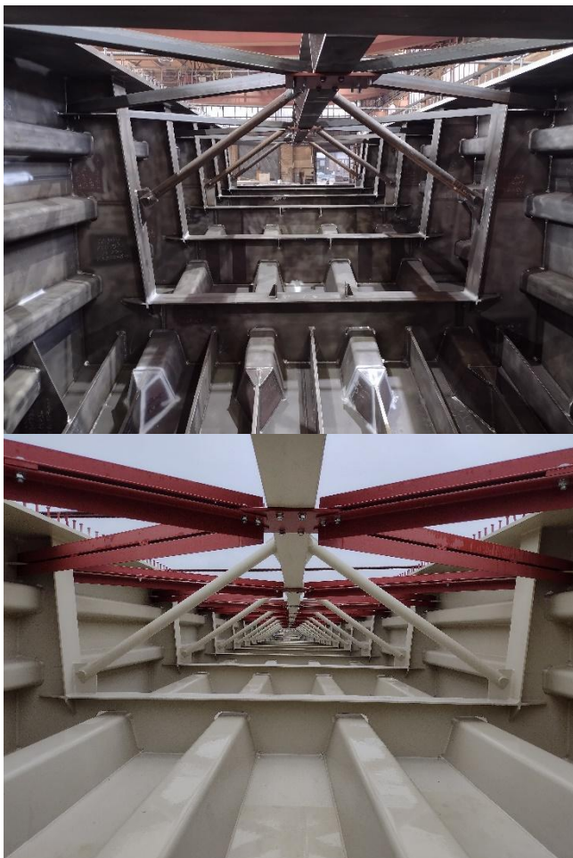
Obr. 3 a 4 - Příčný řez v poli na dílně a na montáži s PKO
