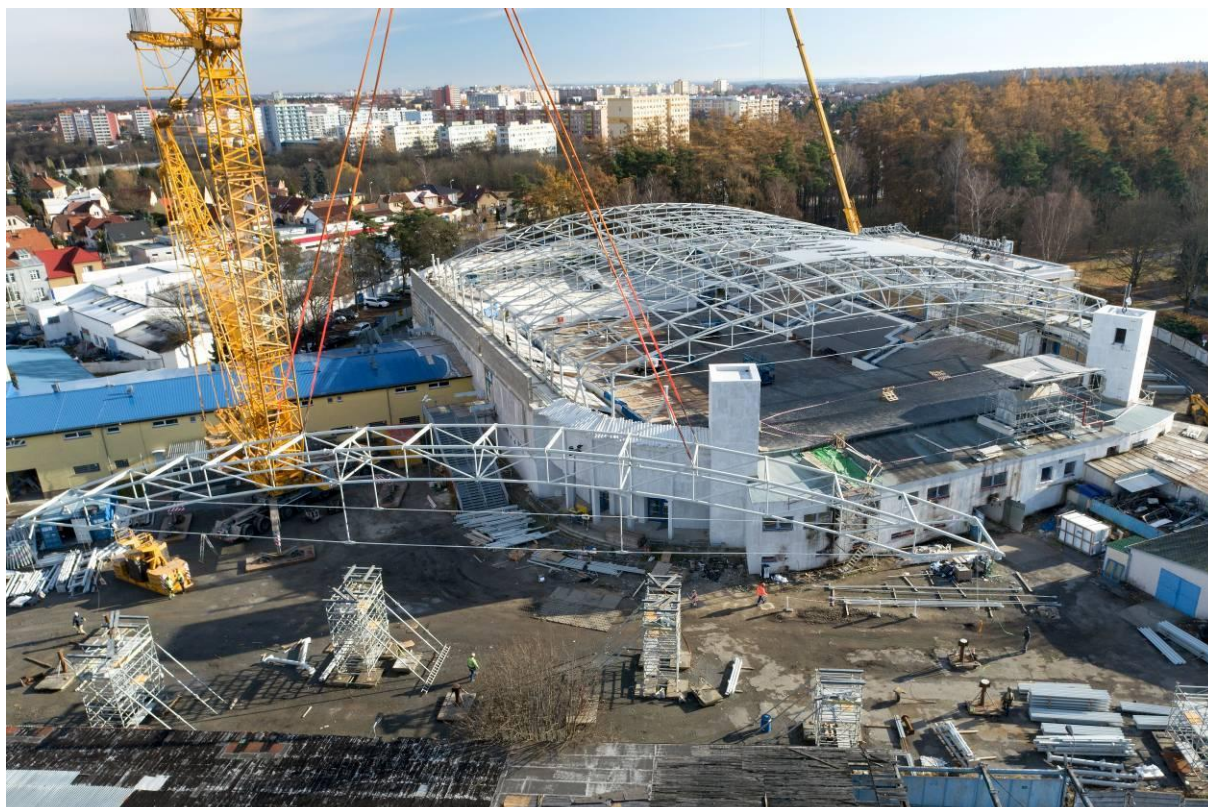
Obr. 10 – montáž a dílčí zdvih ocelové konstrukce haly
