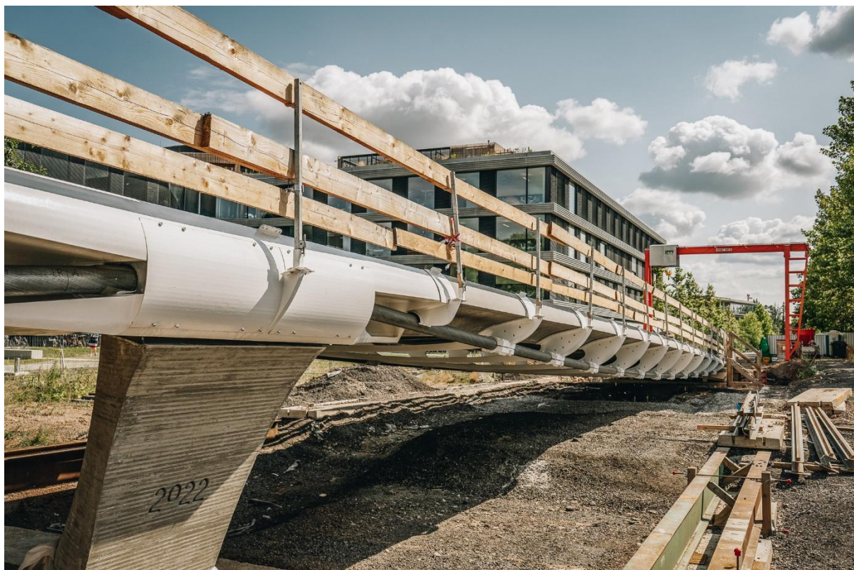
Obr. 3 Prostor staveniště s portálovým jeřábem
