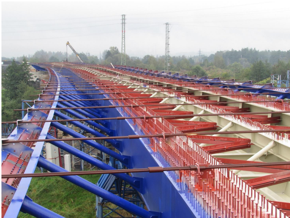
Obr. 11 – Pohled na smontovanou ocelovou konstrukci
